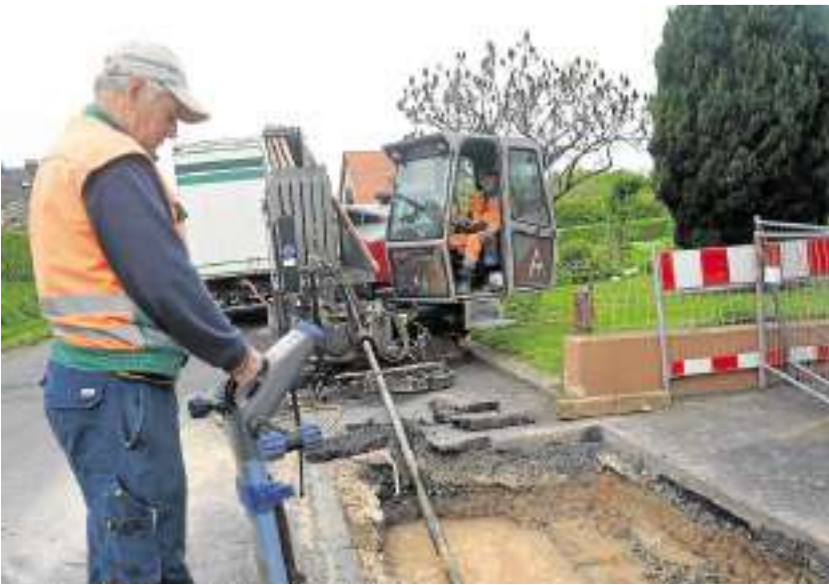
Auf vollen Touren laufen derzeit die Arbeiten in Lingelbach, wo knapp 100 Häuser an das Nahwärmenetz angeschlossen werden. Foto:
